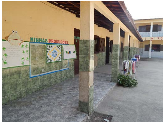
Foto 12- Vista do pátio interno da escola
