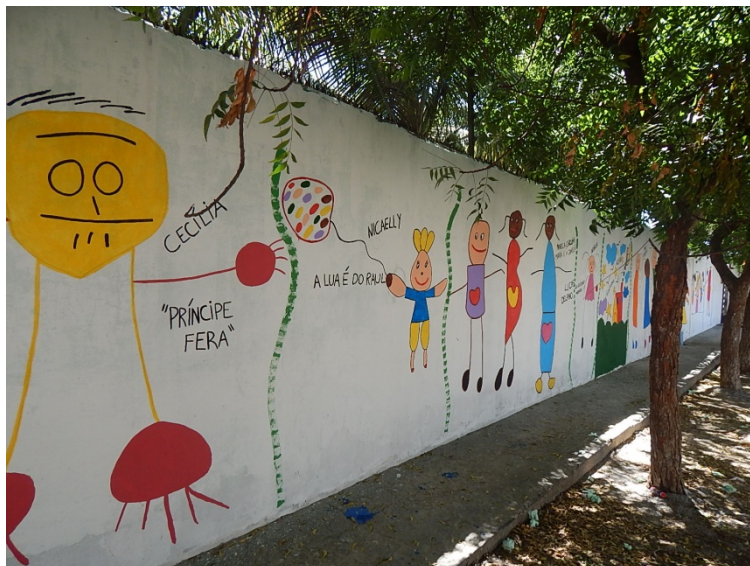
Foto 35 - Pintura externa do muro da escola
