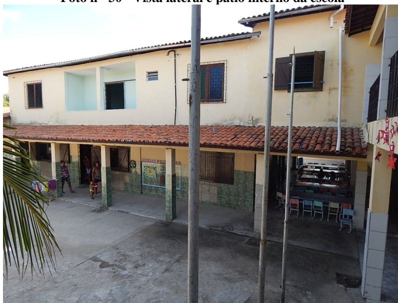
Foto n ° 30 - Vista lateral e pátio interno da escola
